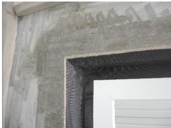
Abbildung 3: Beispielbild eines ausgeführten Standard-Fensteranschlusses. Im Bild zu sehen ist die griffseitige obere Ecke des DK-Kunststofffensters mit Aluminium Vorsatzschale und darauf angeschlossener Dichtfolie.
